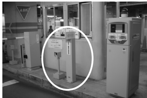
【システム】機械式ゲートのため、二輪車はカードを挿入する検知機を追加設置している。若干、誤動作するケースもあり、管理者が対応している。
