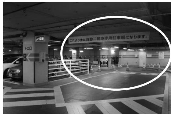
【レイアウト】自動車が進入しないよう看板を掲示し、通路にコーンポストを置いている。
