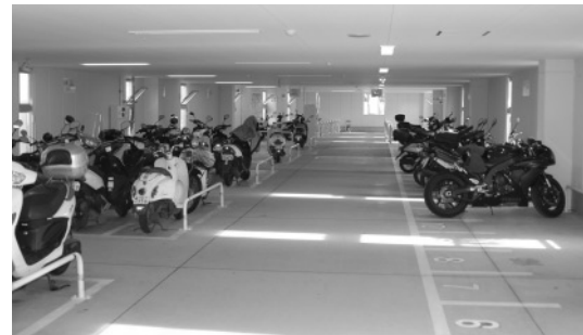
埼玉県鴻巣市・鴻巣駅東口自転車駐車場 原付と自動二輪車合わせて97台を収容可能。
