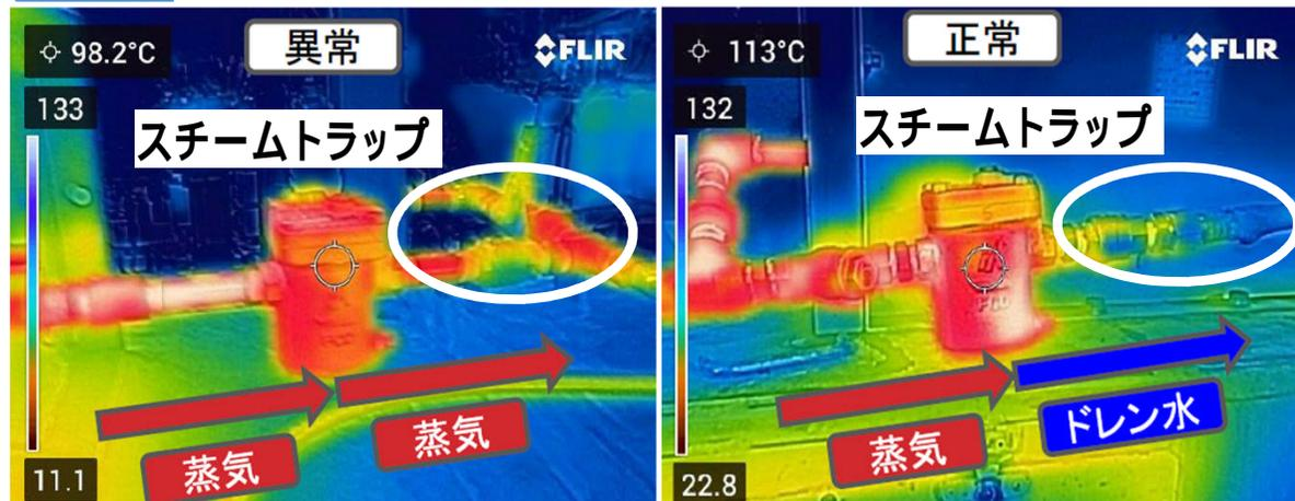
**サーモカメラ**でスチームトラップ稼働良否判定
