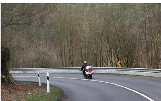
二輪車に適した安全バリア：二輪車ライダーは支柱への衝突から保護される
